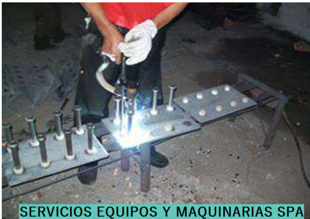
SERVICIOS EQUIPOS Y MAQUINARIAS SPA
